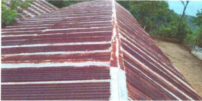
Foto 1: SUSTITUCION DE LAMINAS, QUE ESTAN DESPERFECTAS
